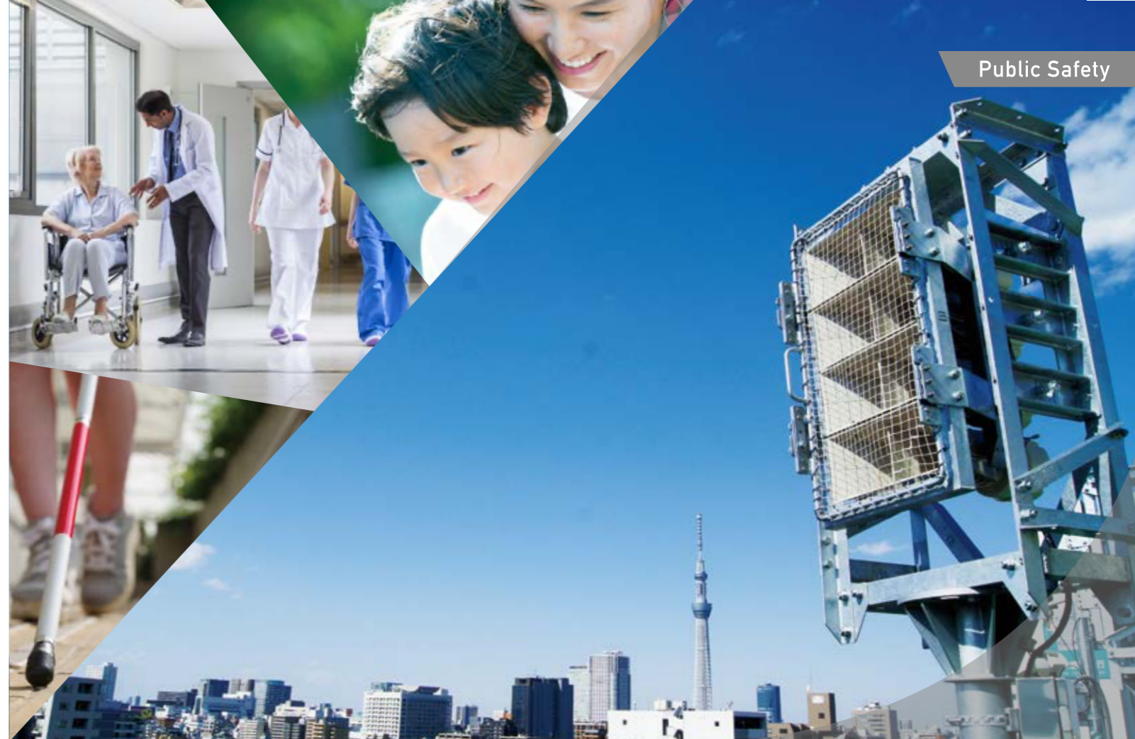
ホーンアレイスピーカー(東京都江東区 防災放送設備)
